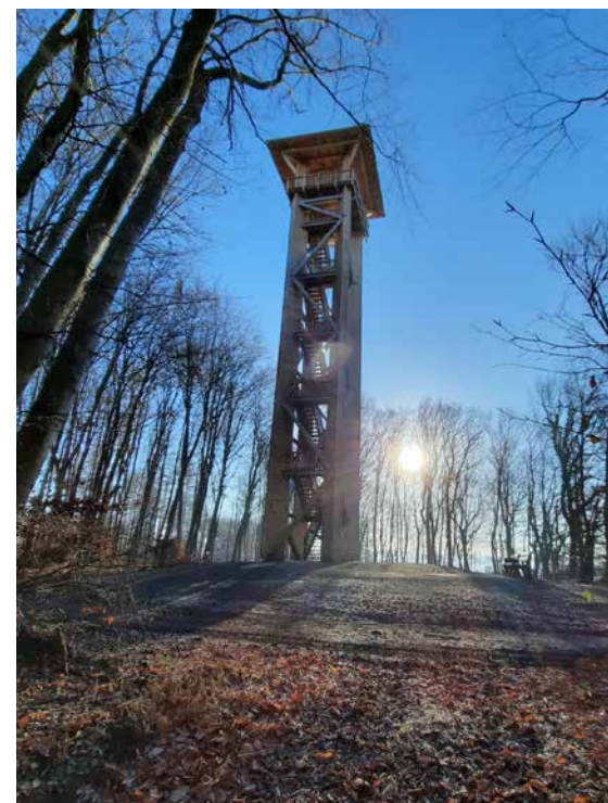
Einige Stufen zu erklimmen gibt es beim Aussichtsturm mit Blick über das Eggetal
